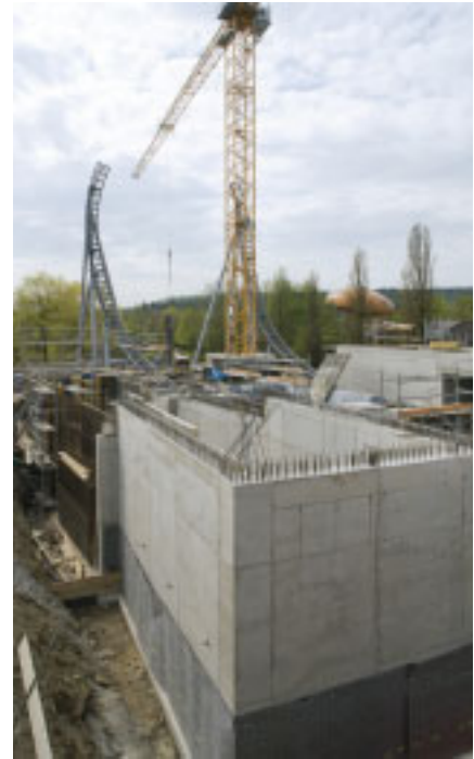
Nach Fertigstellung ist von den Betonarbeiten nicht mehr viel zu sehen.
