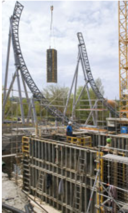
Eine besondere Herausforderung für das Bauunternehmen Amos war die sehr kurze Bauzeit von nur sechs Monaten von September 2012 bis März 2013.
