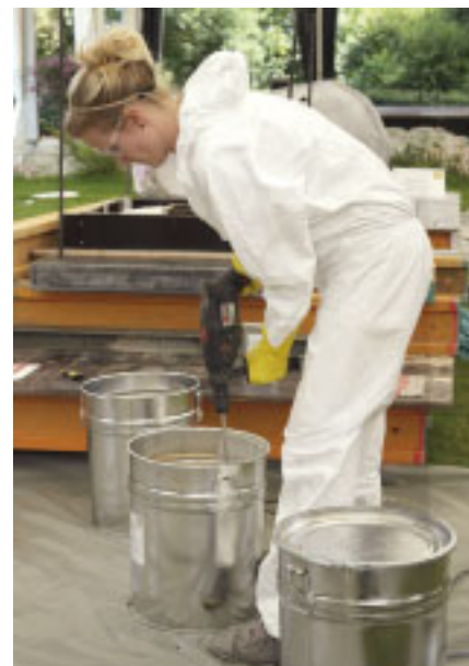
NOEplast flüssig besteht aus zwei Komponenten, die erst bei Anwendung miteinander vermischt werden. (Foto: braun|steine, Amstetten; NOE-Schaltechnik, Süssen)
