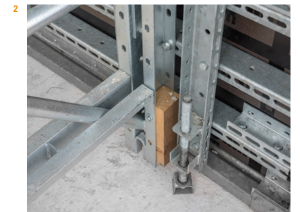
1 Bovenste centering kan over de wand 2 Geïntegreerde hoogtespindel voorzijde
