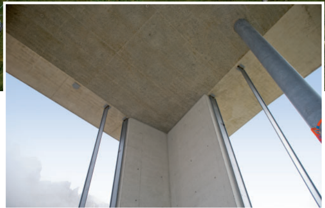
Die mit der NOEplast Putzstruktur Trier 3 strukturierte Deckenunterseite sorgt dafür, dass in der Halle eine gute Raumakustik herrscht. Insgesamt wurden ca. 400 m 2 Strukturmatrizen eingesetzt. Einheitliche Mattengrößen strukturieren die Decke zusätzlich.
