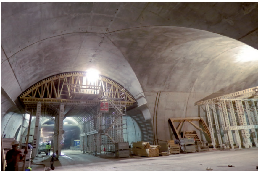
Fertiggestelltes Kreuzgewölbe in Pannenbucht 2 mit Lüfterstollen
