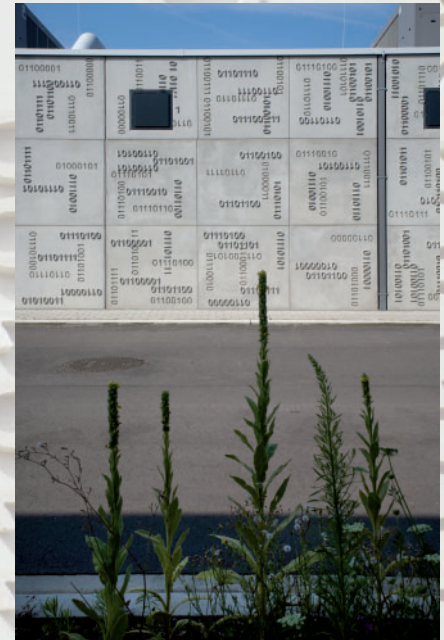
Eine Beton-Oberfläche die neugierig macht. Was bedeuten die Zahlencodes, was verbirgt sich im Gebäude?
