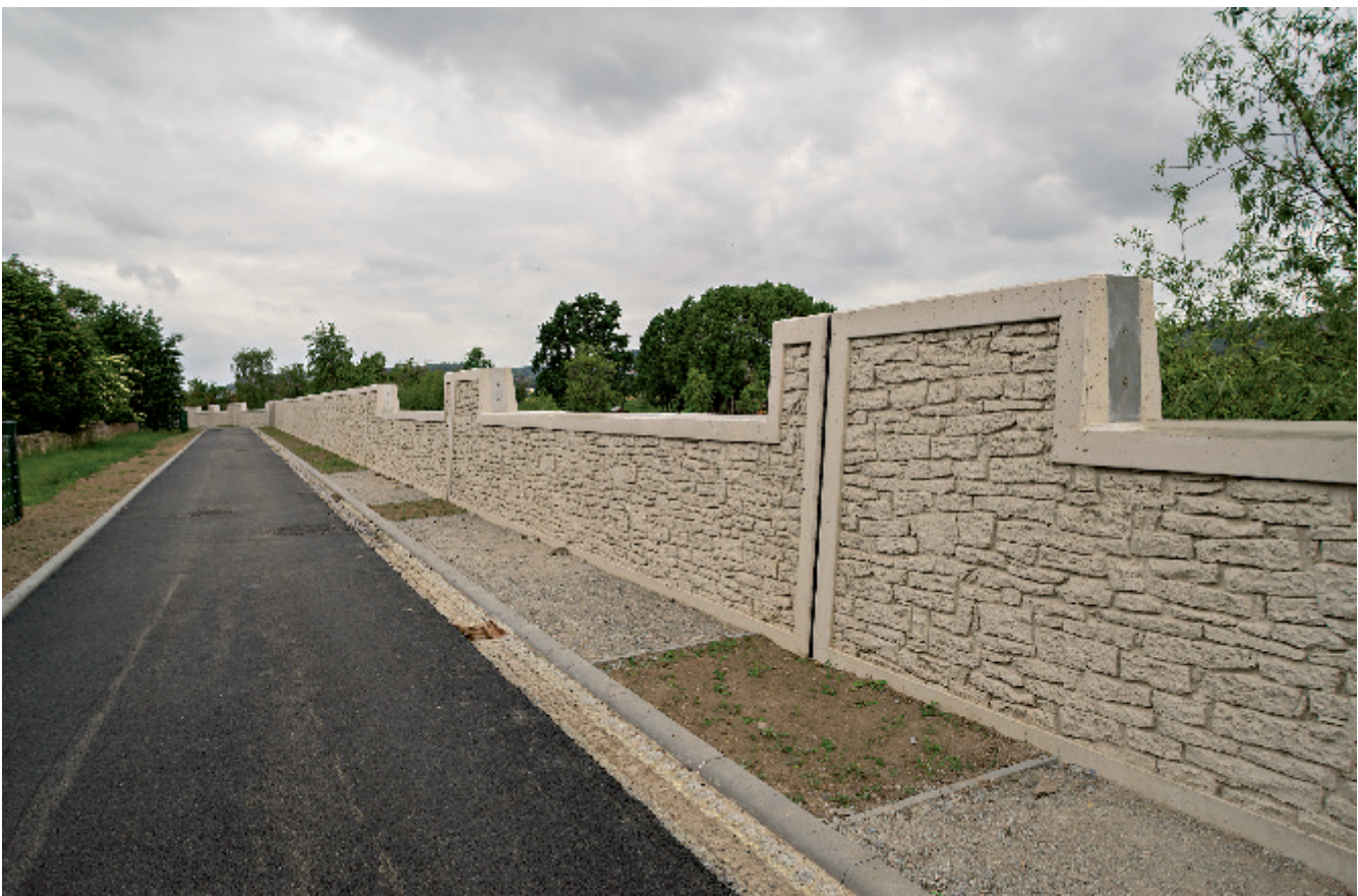
Die Elbdeiche bei Cossebaude bieten nicht nur Schutz vor einem 100-jährigen Hochwasser, sondern überzeugen auch durch eine optisch ansprechende Gestaltung.
