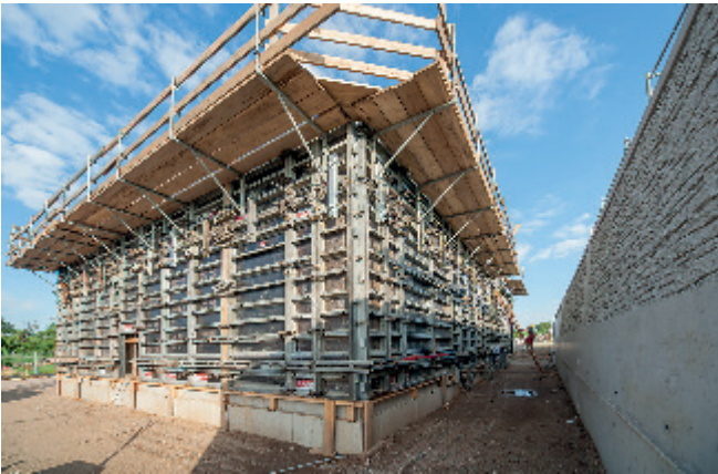
Für die Pumpengebäude an den Enden des Elbdeiches hatte sich das ausführende Bauunternehmen für das bewährte NOEtop Schalsystem entschieden.
