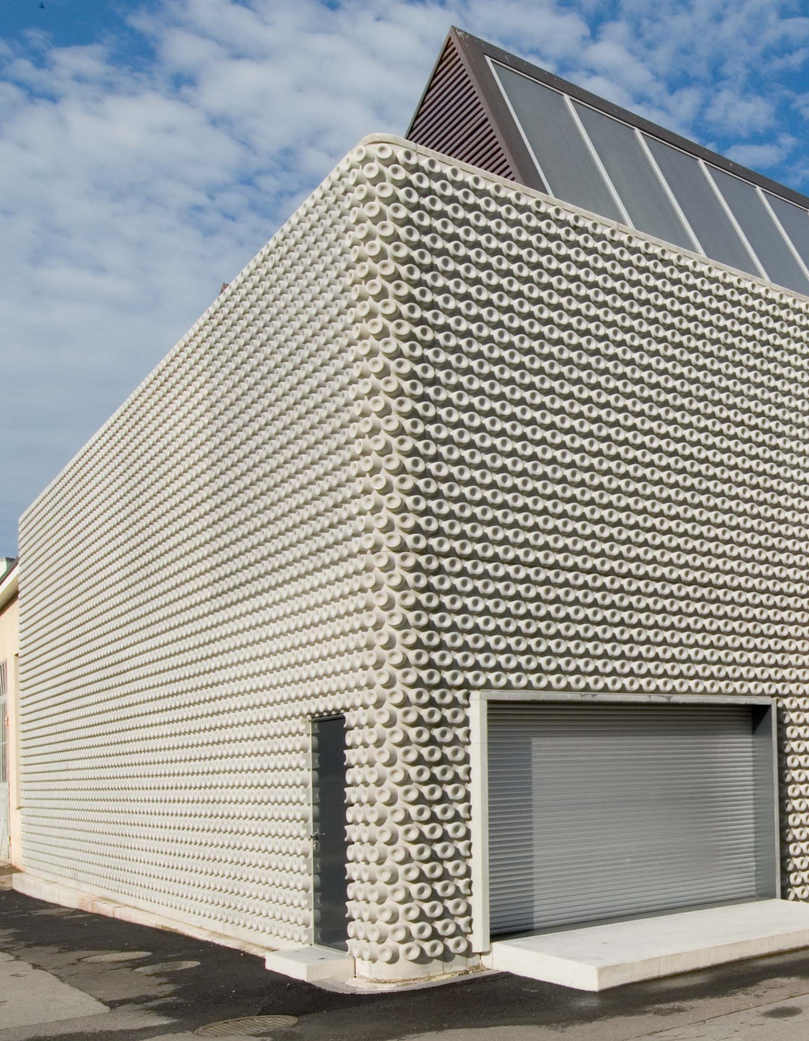
Mit Noppen modellierte Fassade der Kunstgalerie Uetikon am Zürichsee, Schweiz. Realisiert mit NOEplast Strukturmatrizen.
