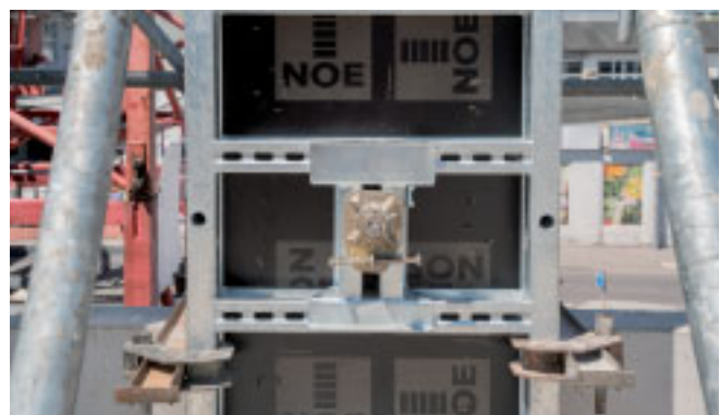
Einsatz der NOEtop EinsA mit Spannlochbrücke an einer Standardschaltafel.
