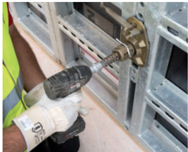
Einsatz der NOEtop EinsA mit Spannlochbrücke an einer Standardschaltafel.
