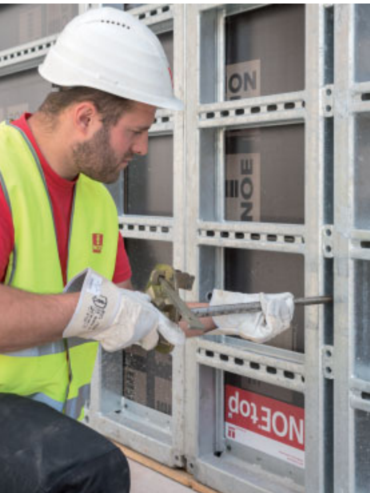
Setzen des konischen Ankerstabes und der Stellmutter zum Schließen der Schalung an einer NOEtop Großflächen-Schaltafel.
