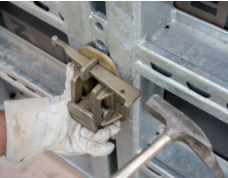
Befestigung des Schwenklagers zur Aufnahme des konischen Ankerstabes an einer NOEtop Großflächen-Schaltafel.
