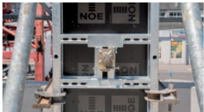
Utilisation du bride d'entretoisement NOEtop EinsA sur un panneaux de coffrage NOEtop.
