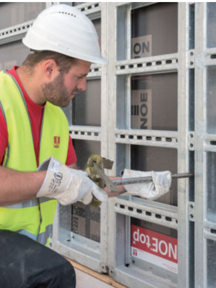
Mise en place de la tige d'ancrage conique et de l'écrou de réglage pour verrouiller le coffrage sur un panneau de coffrage de grande superficie NOEtop.
