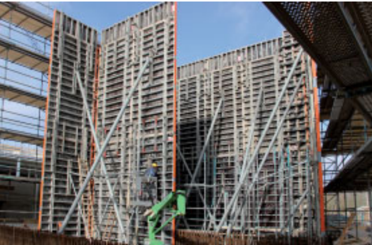
Des étais BKS NOE ont été mis en œuvre pour l'étalement.
