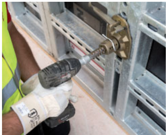
Utilisation du bride d'entretoisement NOEtop EinsA sur un panneaux de coffrage NOEtop.
