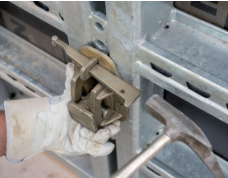
Fixation d'un palier pivotant pour la réception d'une tige d'ancrage conique sur un panneau de coffrage de grande superficie NOEtop.
