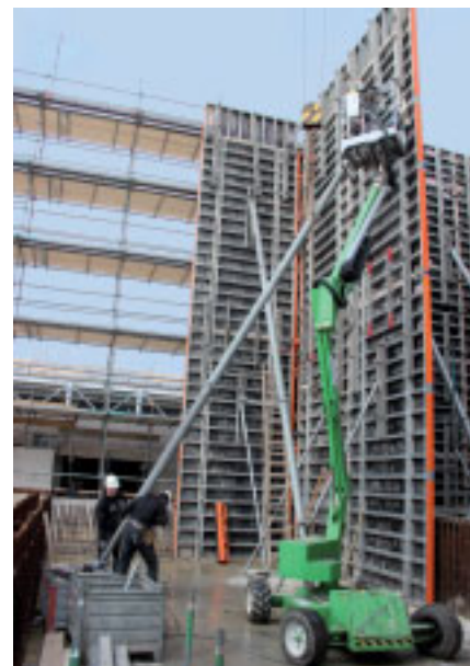
Des chiffres imposants : 11,50 m de hauteur de coffrage, 0,60 m d'épaisseur de paroi bétonnés en l'espace de 36 heures.
