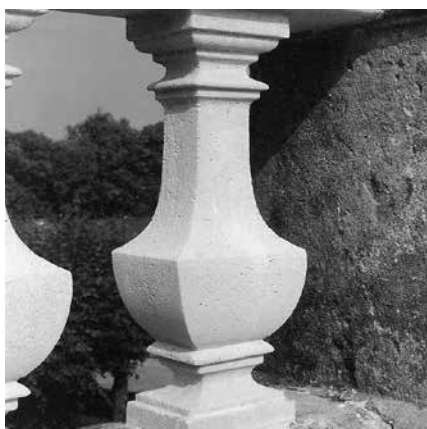
Met behulp van wit cement, zand en door zandstralen kunnen perfecte reproducties worden gemaakt.
