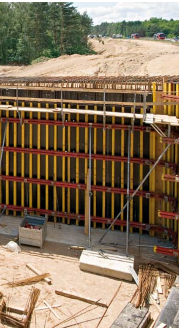
Schalung der Hilfsflügel am Bestand mit NOE-Trägerschalung.
