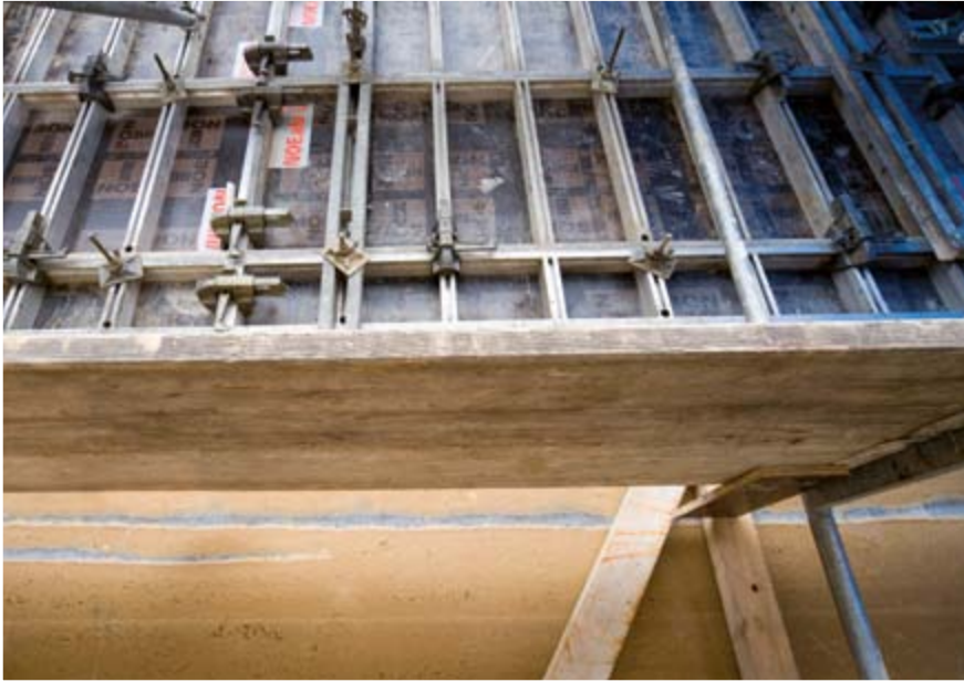
Beim Objekt in Bludenz überzeugte die NOEalu L Handschalung durch leichtes Handling.
