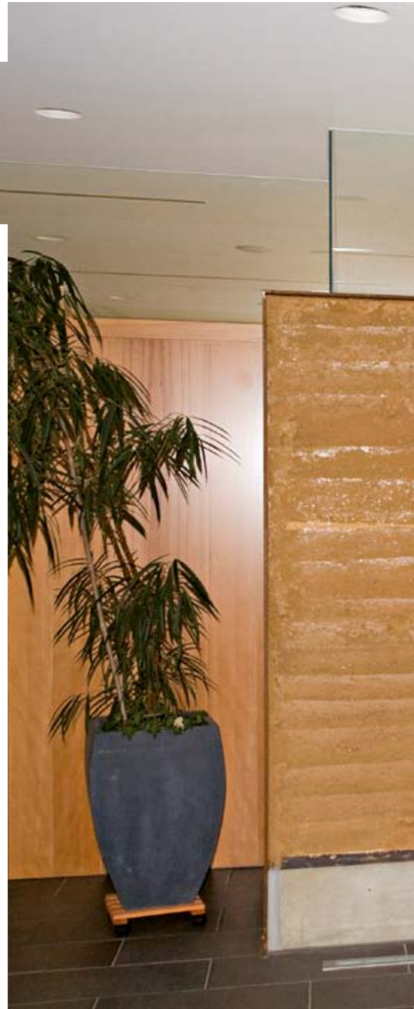
Deutlich zeichnen sich die eingebrachten Lehm-Schichten in der Stampflehmwand ab. Dies ist das Markenzeichen der Stampflehmwände.
