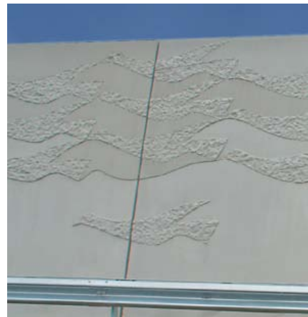
Einem Puzzle ähnlich wurden fünf Schalungsformen aus den NOEplast Strukturmatrizen Gladbeck und Granit III sowie Multiplex-Platten aufgebaut.
