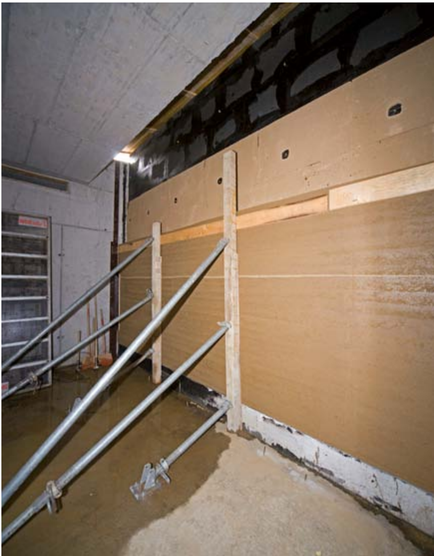
Beeindruckend von ihren Abmessungen her ist die Stampflehmwand der Verabschiedungshalle in Bludenz. Zwölf Wochen wurden benötigt, um diese Wand zu errichten.
