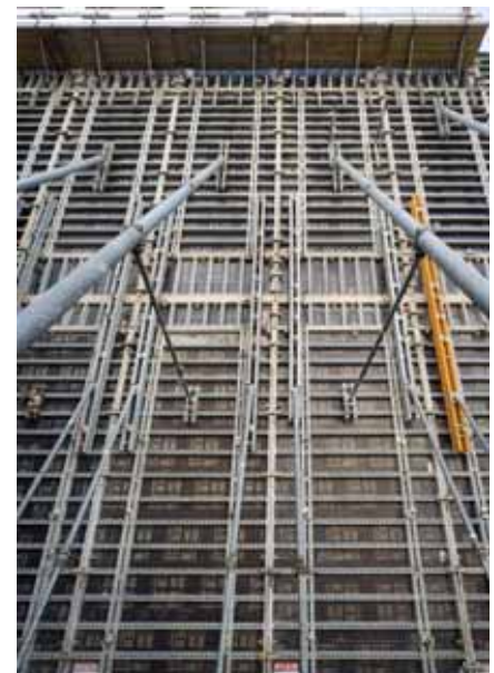
NOEtop Schaltafeln lassen sich stehend und liegend kombinieren, ohne dass das Tafelraster verlassen wird
