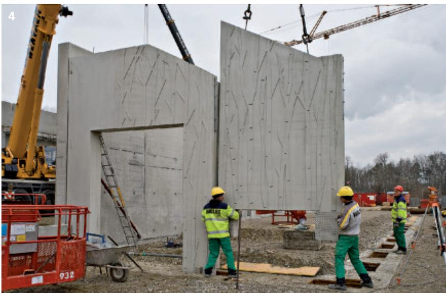
8,43 m. Möglich war dies nur, weil sie die Strukturmatrizen knapp 40-mal wiederverwendeten. Generell können alle NOEplast Strukturmatrizen bis zu 100-mal verwendet werden, was sie äußerst kosteneffizient macht.
