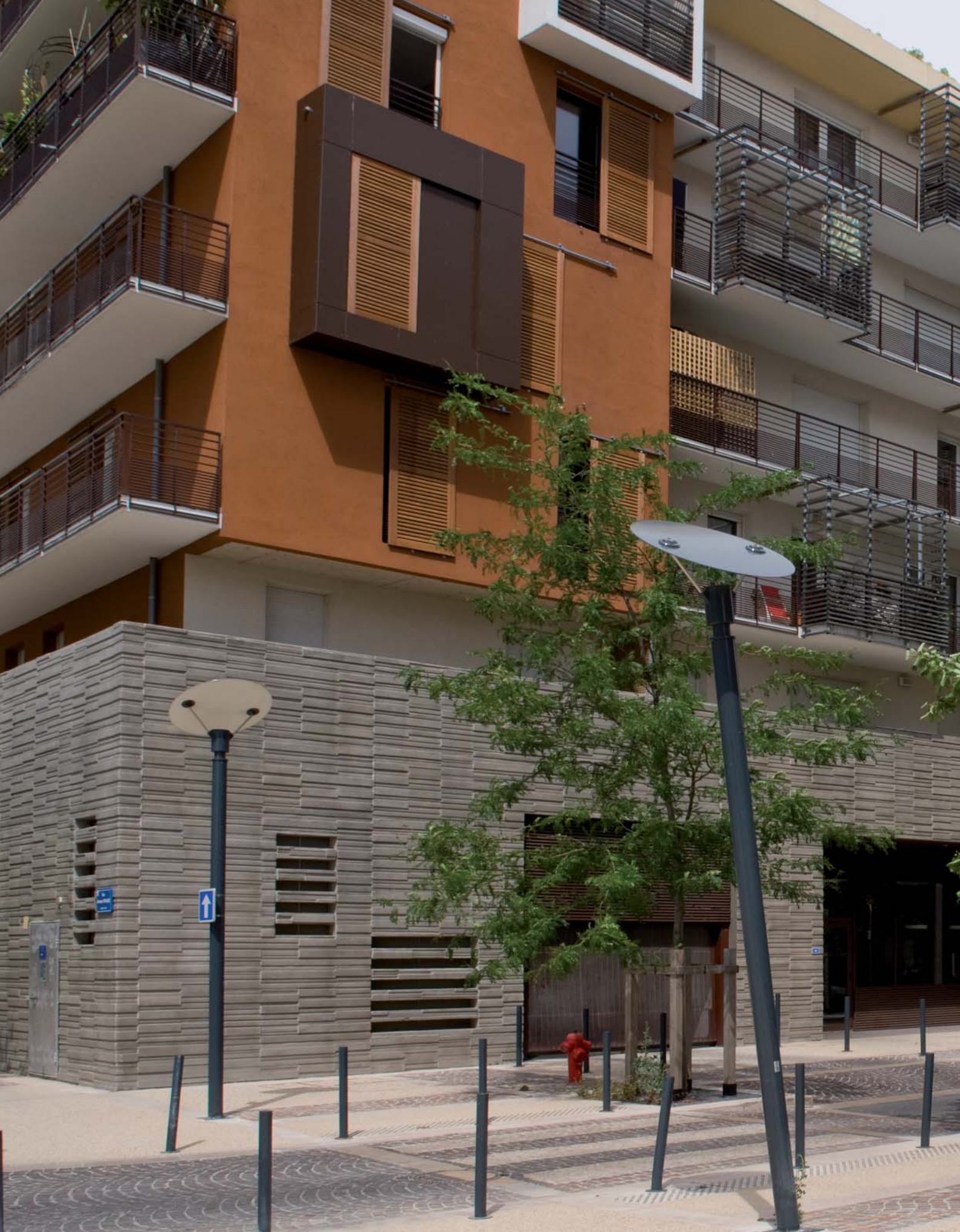
Die Fassaden der Eingangsbereiche einer Wohnanlage in Montpellier erhalten dank der NOEplast Struktur „Bremen“ ein ästhetisches Äußeres.
