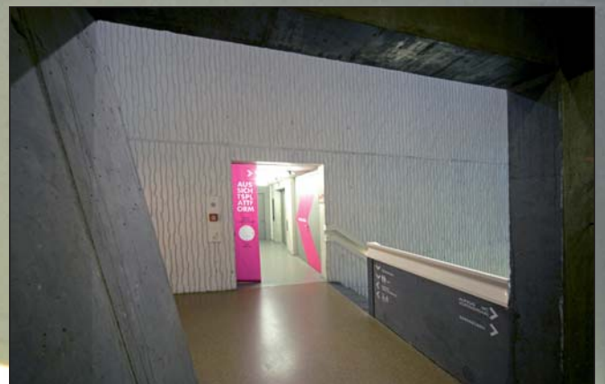
NOEplast Struktur „Amsterdam“ als gestaltendes Element für die Innenarchitektur des Schlosses in Freiberg.
