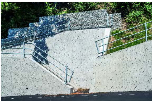
Stützmauer Ollon, Fluêmos, Schweiz
