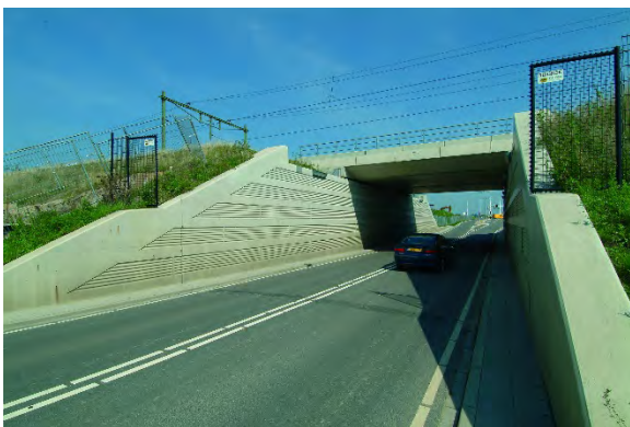
Brücken-Widerlager Houten, Niederlande
