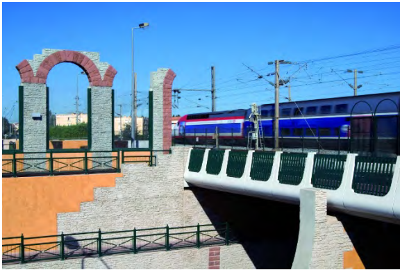
Unterführung Fréjus, Frankreich
