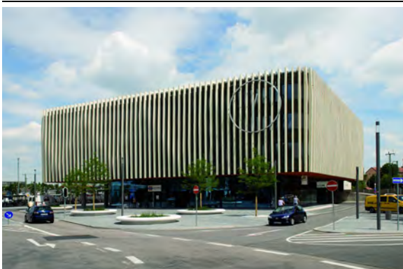
Nordbahnhof Ingolstadt, Deutschland
