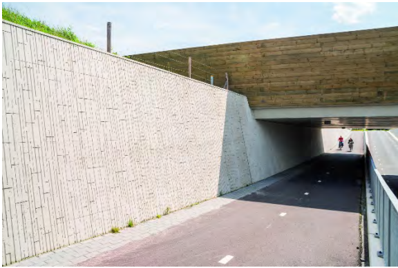
Unterführungen Provinciale Weg 356 (Centrale AS), Holwerd–Nijega, Niederlande
