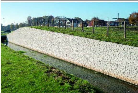
Keerwand Slaperdijk Velsen, Santpoort, Niederlande
