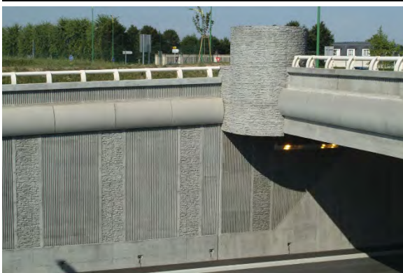
Verkehrswegebau Saint Lô, Frankreich
