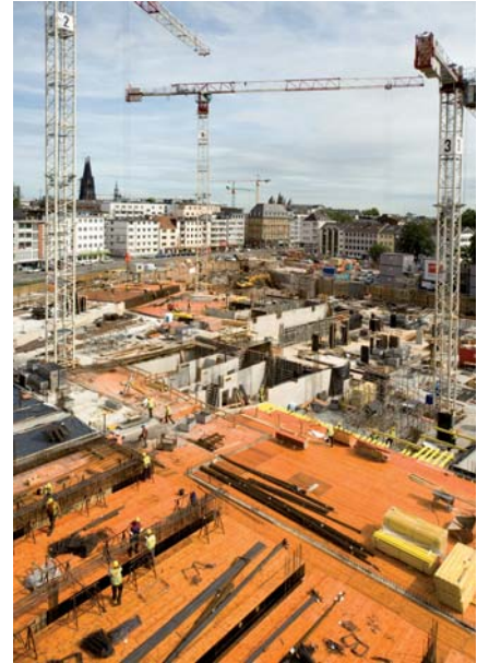
Neben der NOEtop Rahmenschalung setzte Köster GmbH auf der Baustelle Waidmarkt die NOE H 20 Deckenschalung ein.
