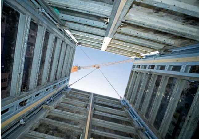
Auf der bauma 2013 in Aktion zu sehen: die NOEtop Ausschalecke. Eine Demontage der Innenschalung für Ausschal- bzw. Umsetzvorgang ist nicht mehr notwendig.
