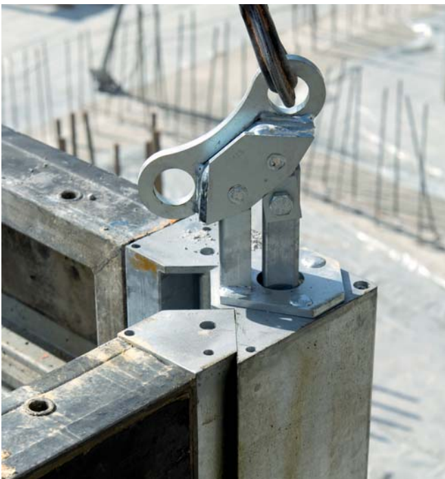
Auf der bauma 2013 in Aktion zu sehen: die NOEtop Ausschalecke. Durch Umhängen des Seilgehänges wird der Einschalzustand mit einem einzigen Kranhub wieder hergestellt.
