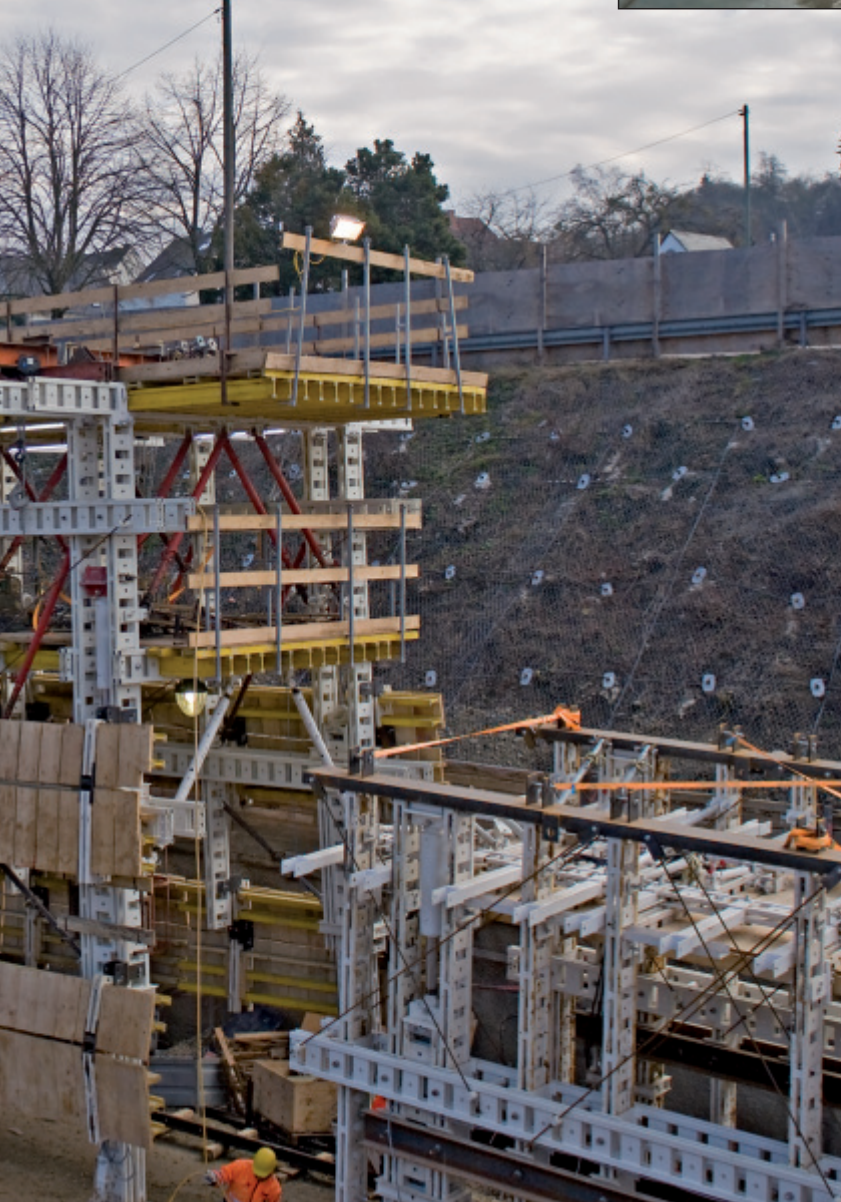
Utilisation comme échafaudage d'encorbellement
