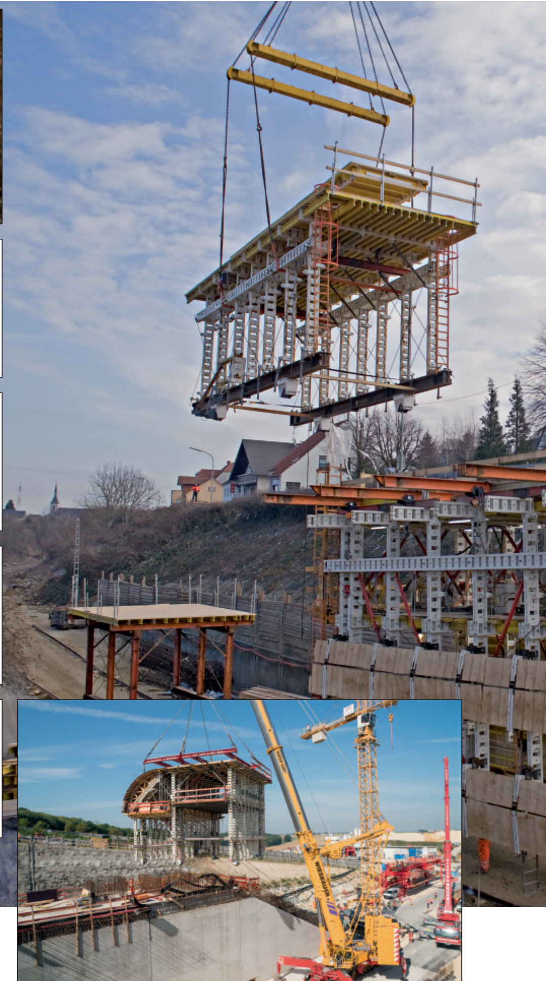
Utilisation comme coffrage de cuvette
