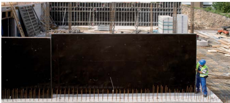
Macht das Ein- und Ausschalen schnell: NOEtop Großflächenelemente mit Größen bis 5,30 x 2,65 m und über 14 m 2 Schalfläche.
