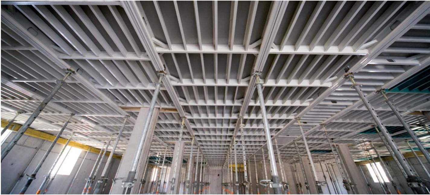
Ergänzen sich ideal: Die NOEdeck Fallkopf-Deckenschalung und der NOEboard Kunststoff-Schalbelag.
