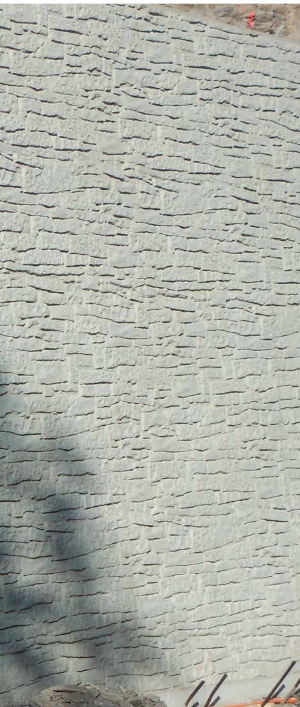
Noch ist es eine Betonwand, wenn diese etwas „Patina“ angesetzt hat, erkennt nur noch der Fachmann, dass es sich um eine Stützmauer aus Beton und nicht um eine gemauerte Stützmauer handelt.
