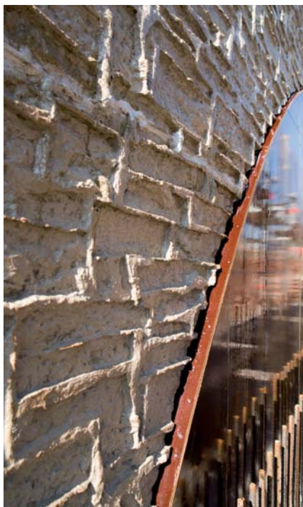
Einem Trockenmauerwerk nachempfunden ist die Strukturmatrize Murus Romanus. An der Stützmauer in Pirmasens dazu benutzt, um gemauerte Bögen zu symbolisieren.
