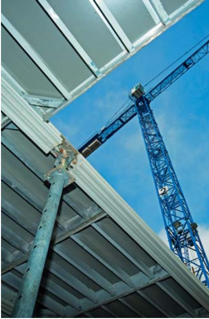
NOE rüstet seine NOEdeck Deckenschal- tafeln mit NOEboard, dem High Tech Kunststoff-Schalbelag aus.
