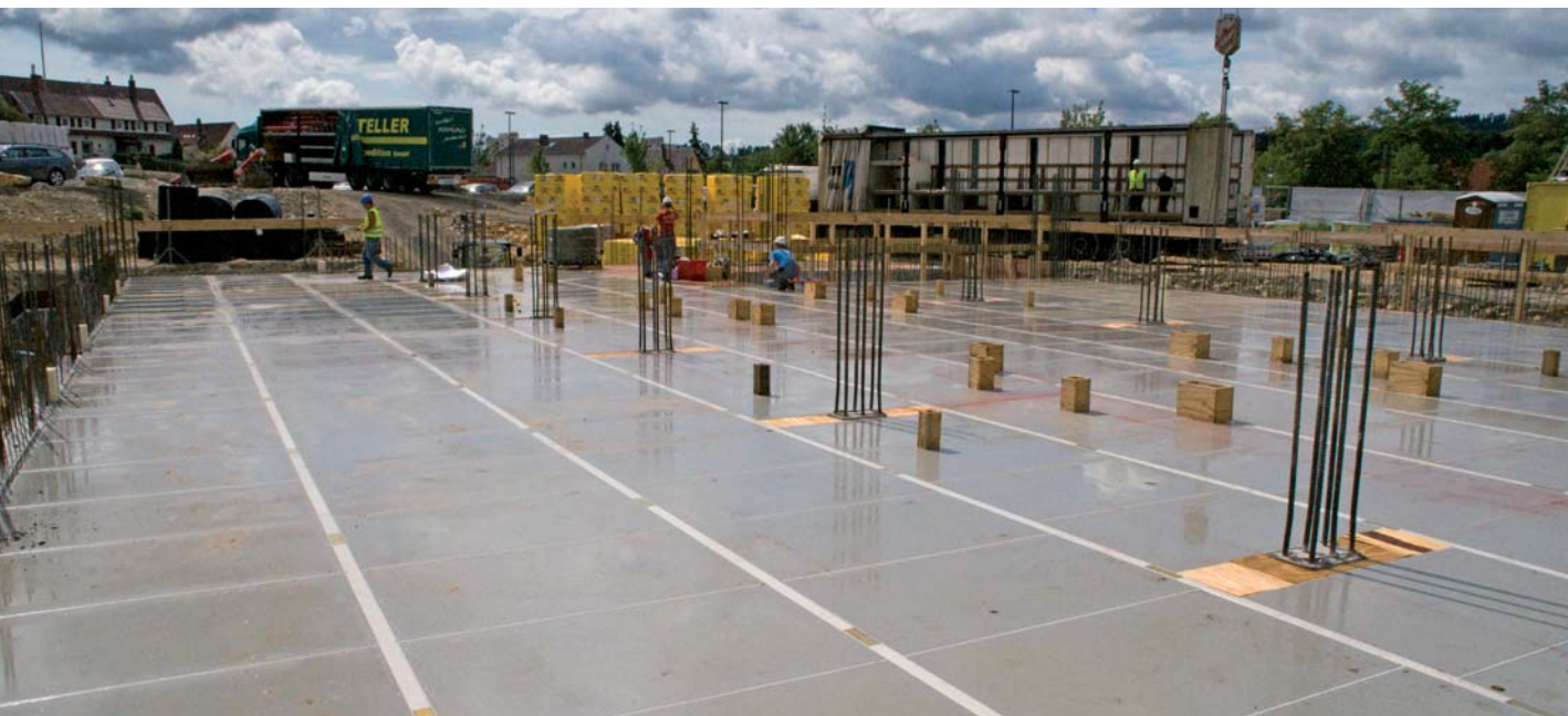
Standardmäßig wird die NOEdeck Deckenschalung mit NOEboard – dem High Tech Schalbelag von NOE – belegt.
