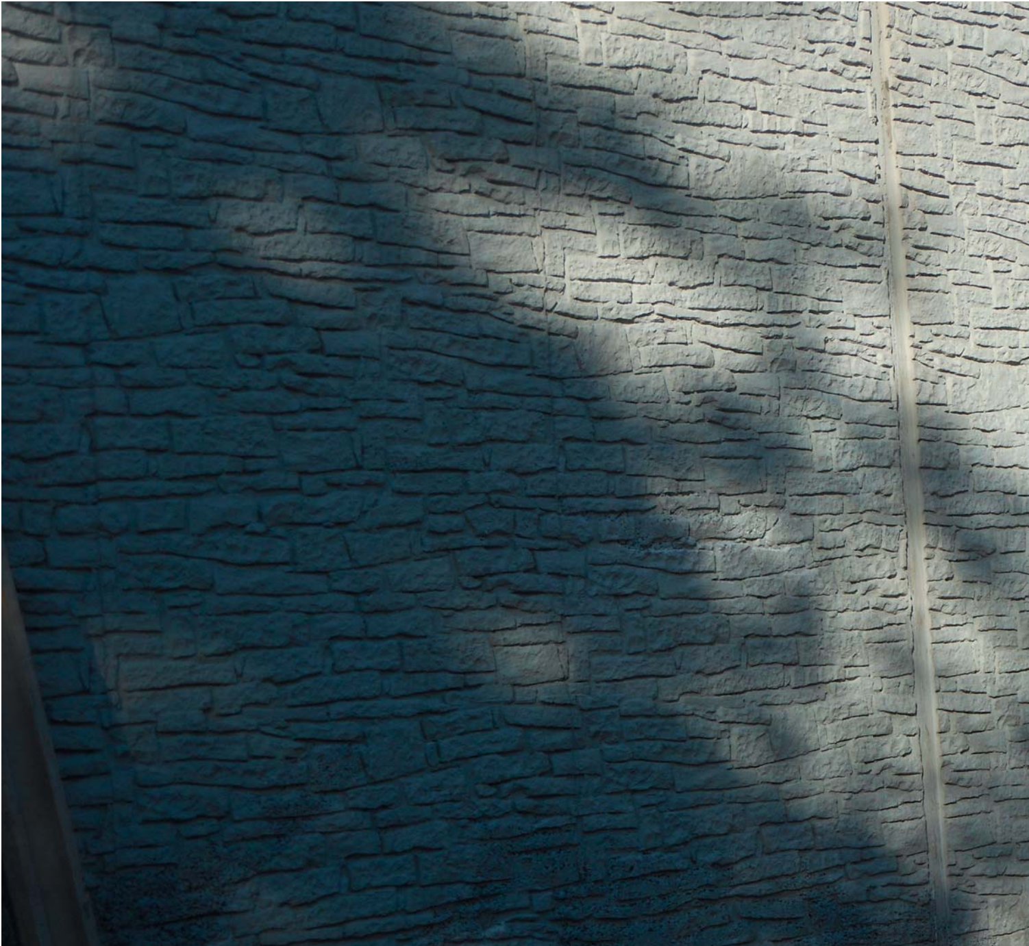
Mit einer 10 cm breiten Scheinfuge wurden Höhenversprünge der „Steinreihen“ ausgeglichen, um die Optik einer durchgehend gemauerten Wand zu erreichen.
