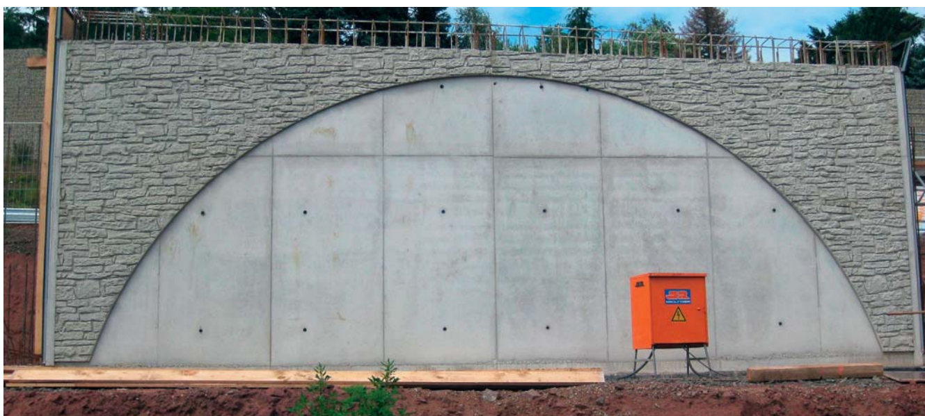
In Höhe und Breite lässt sich die NOEplast Strukturmatrize Murus Romanus beliebig erweitern. (Foto: Bauunternehmen Josef Rädlinger, Vilshofen)
