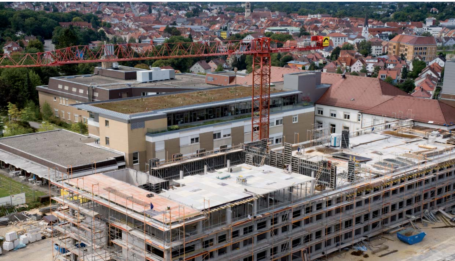
In fünf Monaten musste der Rohbau des neuen Bettenhauses des Klinikums für den Landkreis Tuttlingen erstellt werden.
