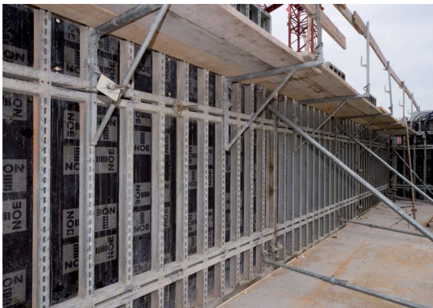
In allen NOEtop Großflächenelementen ist die Gurtung integriert. Dies bedeutet frei wählbare Anordnung der Spannstellen und einhäuptiges Schalen bis 3,31 m Höhe ohne zusätzliche Gurtung.
