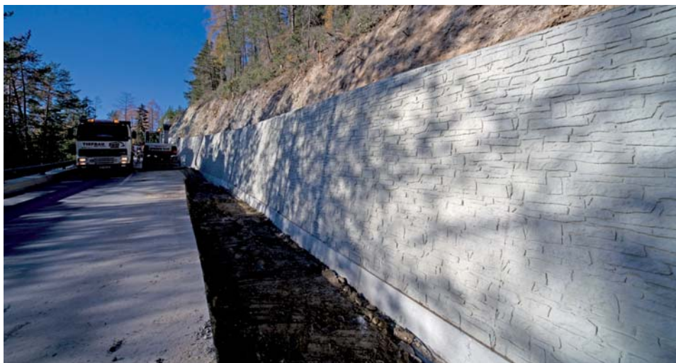
Noch ist es eine Betonwand, wenn diese etwas „Patina“ angesetzt hat, erkennt nur noch der Fachmann, dass es sich um eine Stützmauer aus Beton und nicht um eine gemauerte Stützmauer handelt.
