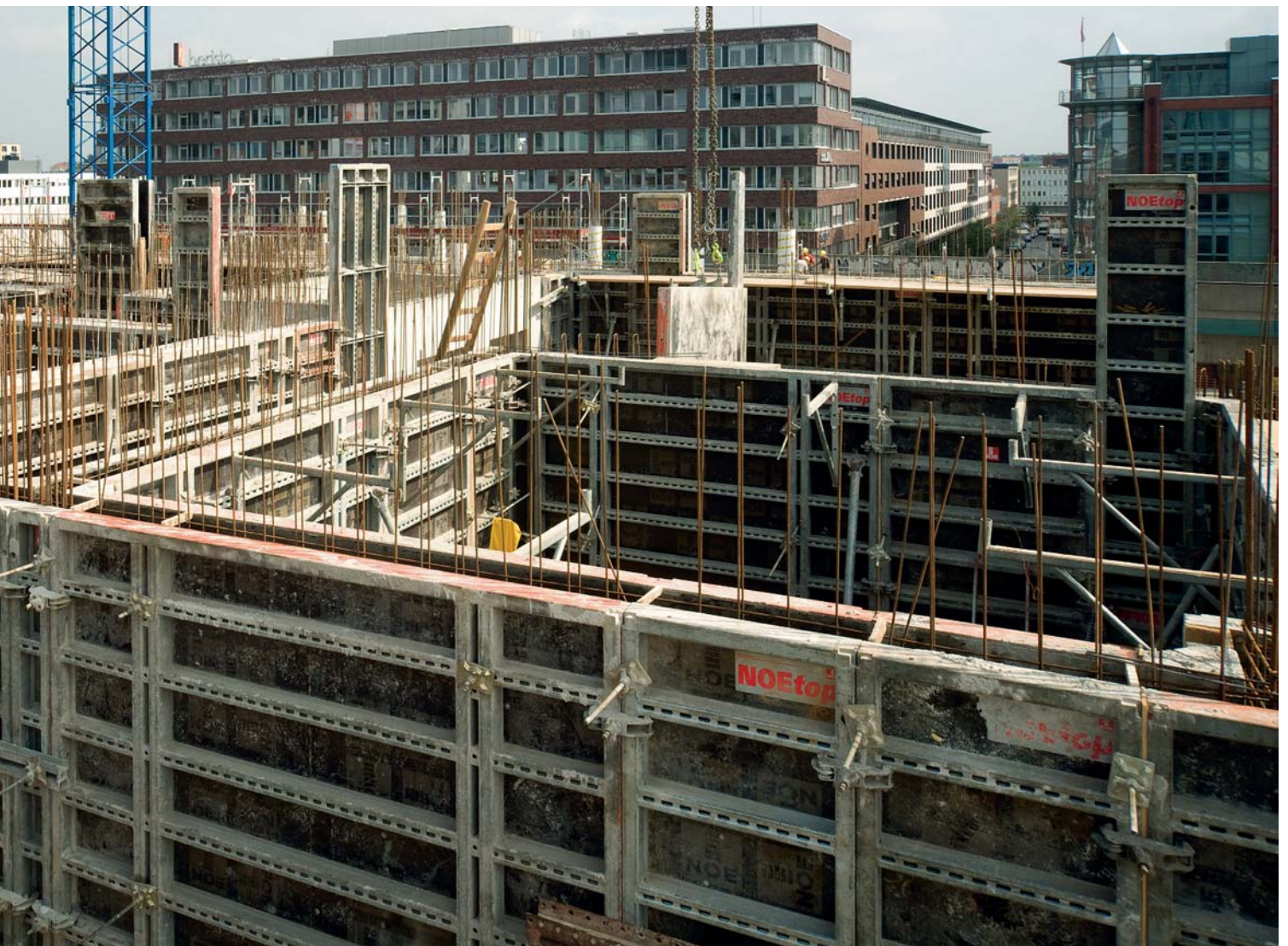
NOE rüstet seine NOEdeck Deckenschal- tafeln mit NOEboard, dem High Tech Kunststoff-Schalbelag aus.
