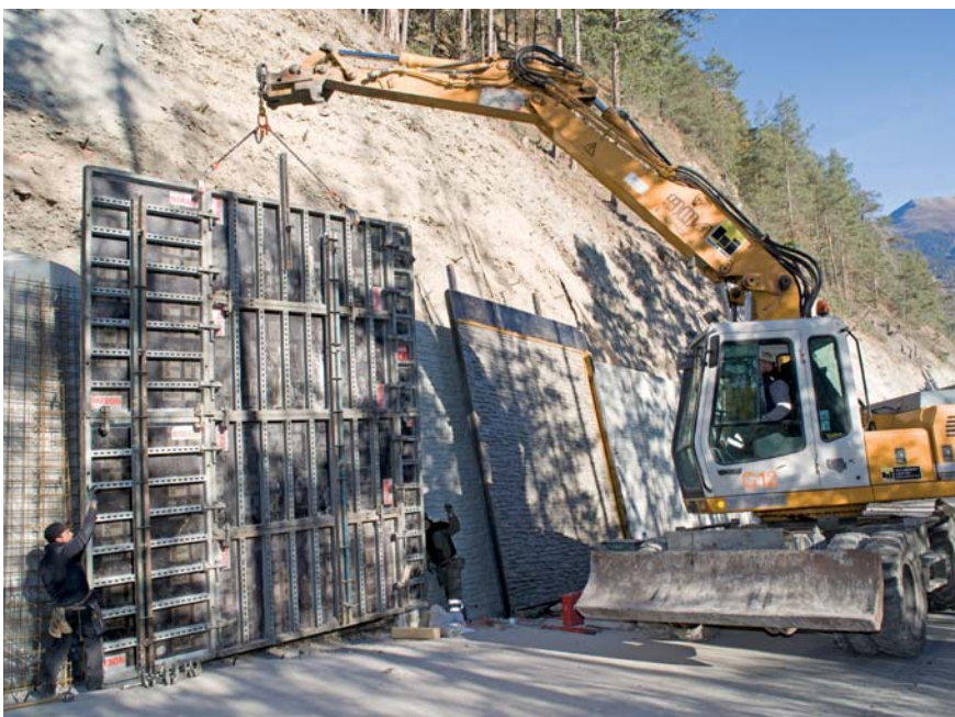
Für den Bau der 800 m langen Betonwand waren nur drei Sätze NOEplast Strukturmatrizen einsatzfertig montiert auf NOEtop Wandschalung mit einer Länge von ca. acht Meter und einer Höhe von ca. zwei bis fünf Meter erforderlich. Sie wurden bis zu vierzig Mal eingesetzt.
